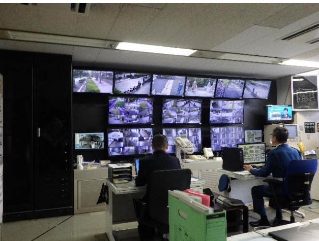
警備室モニター(法務ゾーン1階)
