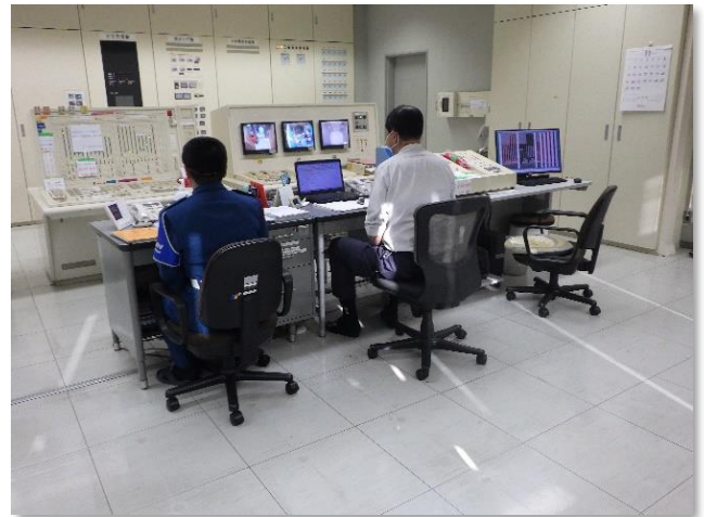
防災センター(検査ゾーン1階)
